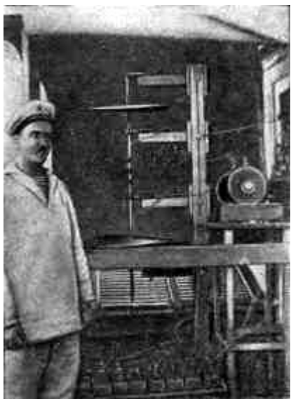
Фотография корабельного передатчика А. С. Попова, применявшегося в опытах по радиосвязи в 1897 г.
