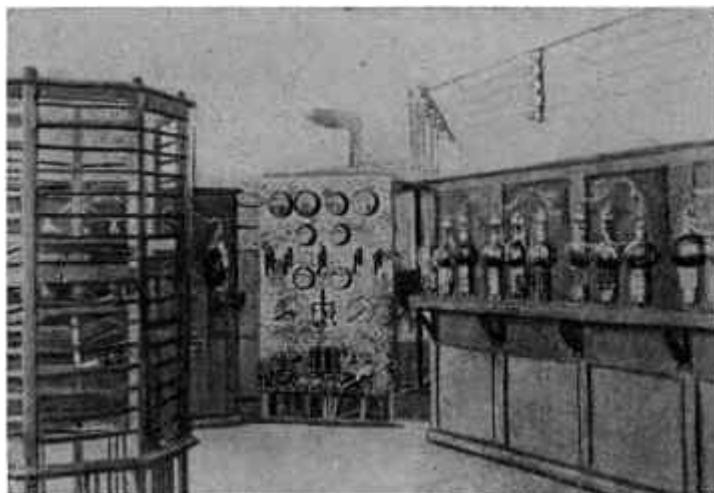
Передатчик первой Московской радиотелефонной станции. Налево — катушки колебательного контура, в центре — щит управления, направо — передатчик.
